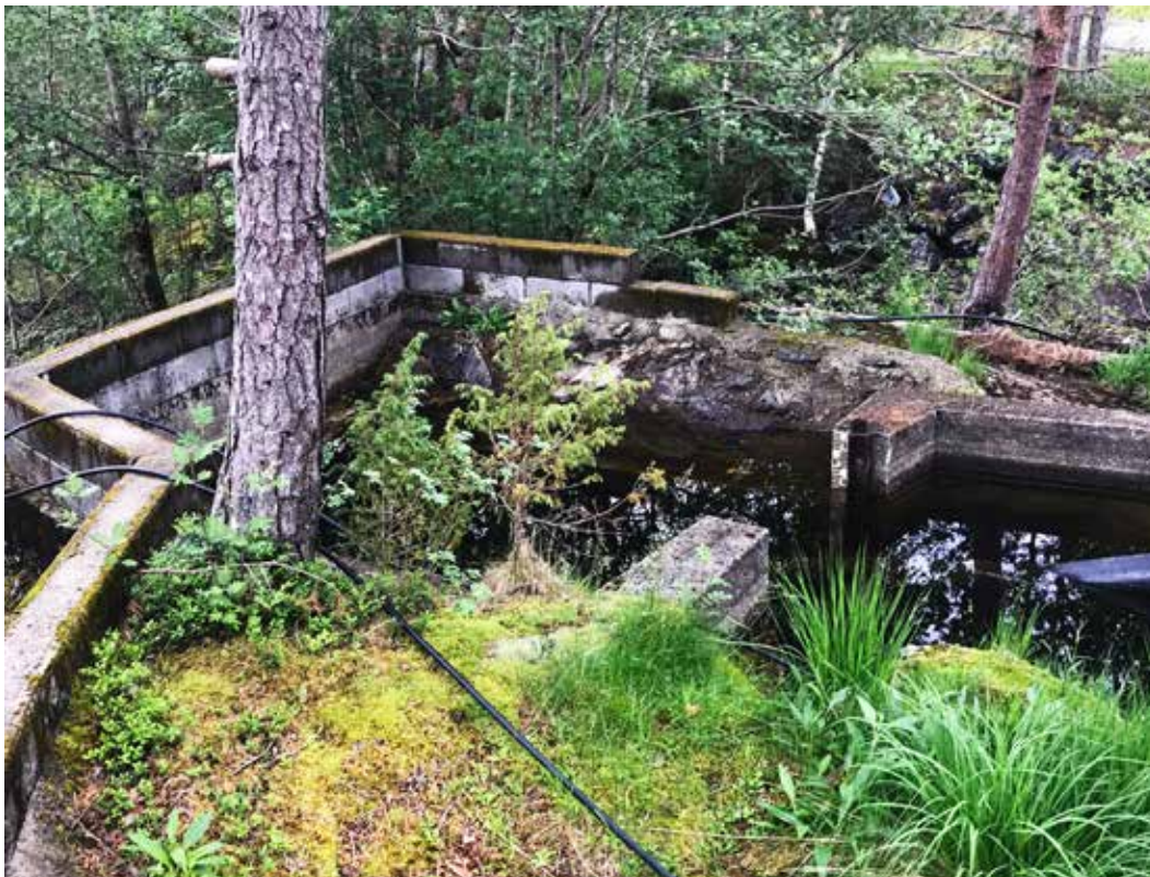
← Plasseringen av målestaven i demningen der rørene for vannuttaket til liten settefisk-anlegget er, 18.–19. juni 2019.
